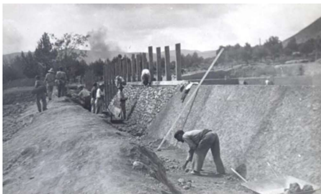
Construcción de la balsa de La Glorieta
