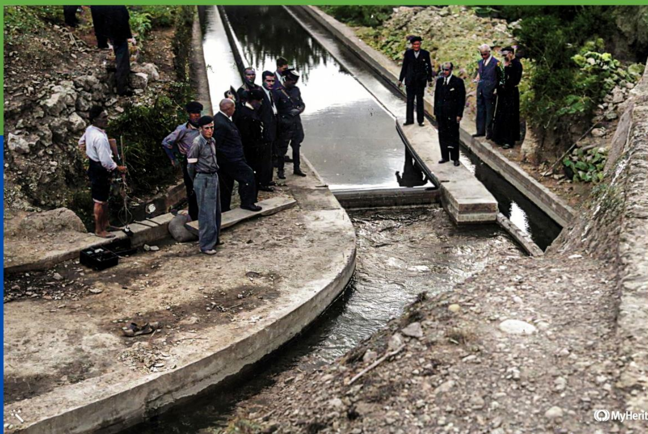
Módulo partidor de las aguas de la acequia de La Esperanza o contracequia, 1942.
