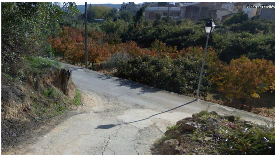
Final de la Actuación. Instalación del nuevo poste P20464-8FVA-250.
