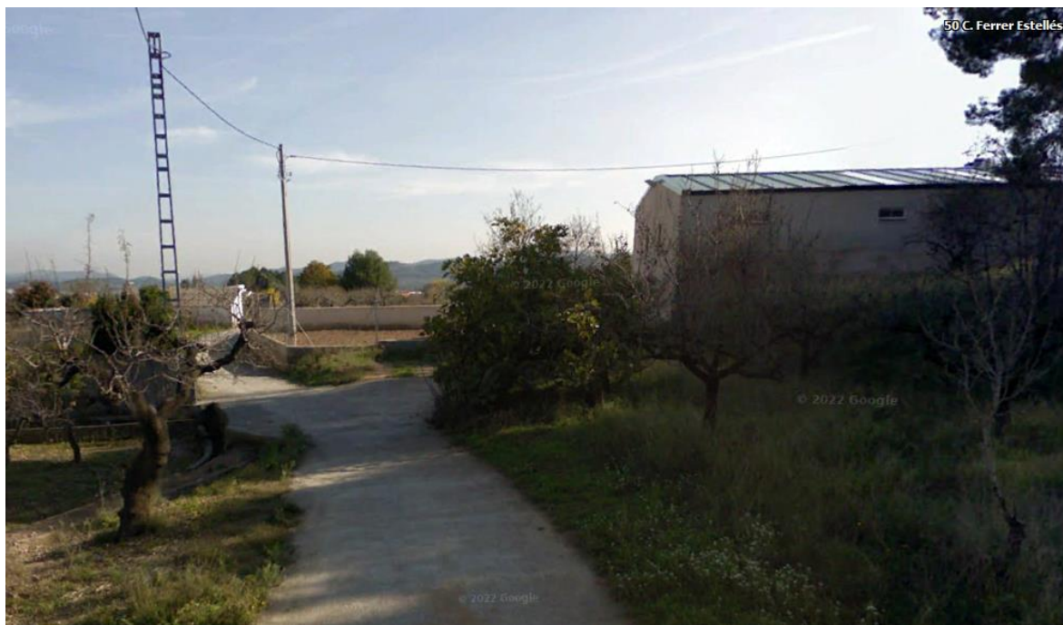
Construcción de la nueva arqueta ARQ-6797-DM y nueva Zanja Tritubo 40, de longitud 238m.
